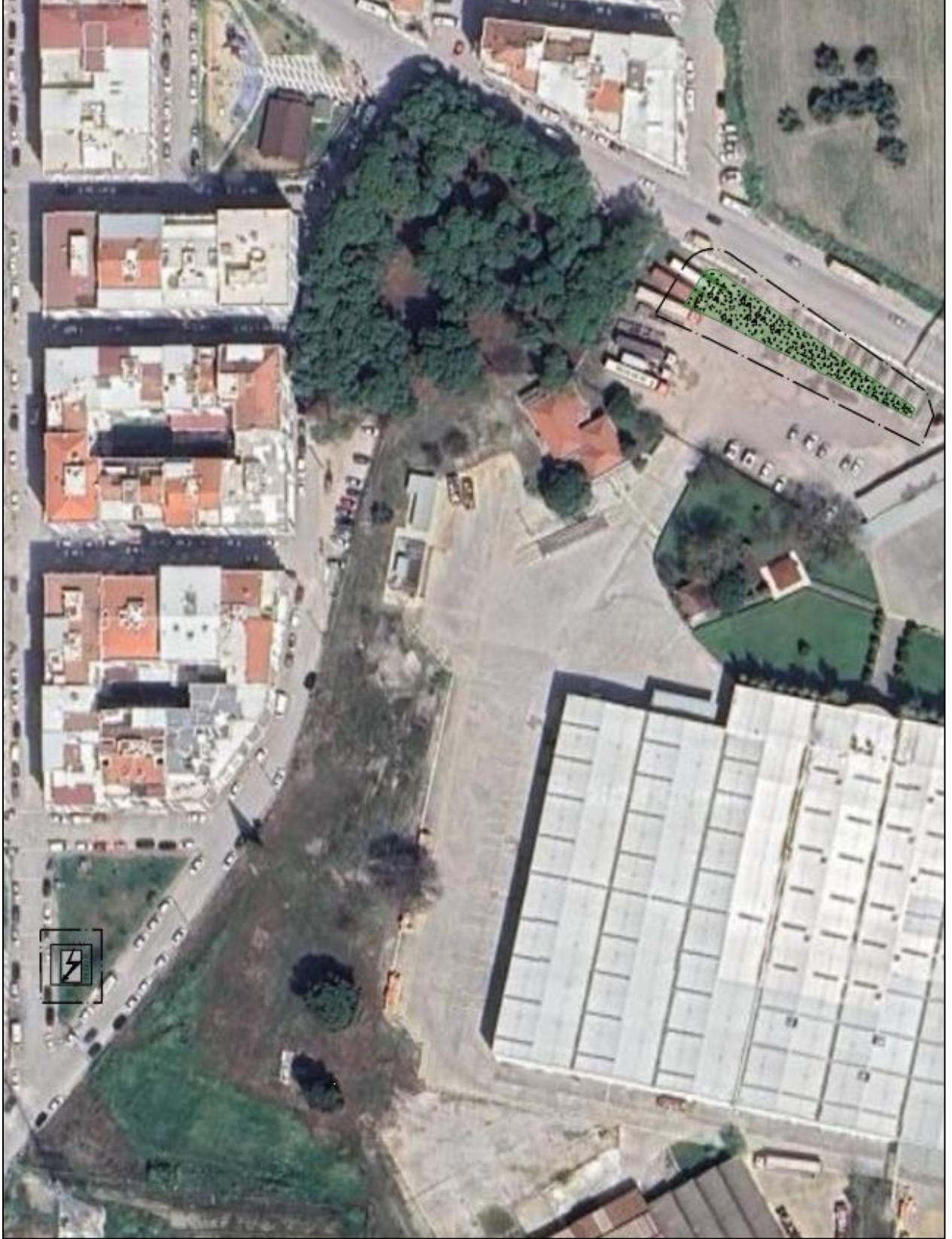
-Trafo Alanının Uydu Görüntüsündeki Konumu-
